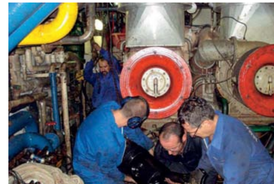
Servicio de máquinas trabajando en una reparación.
