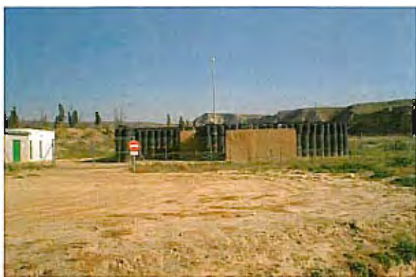
Casa de Goma o Kiling House en la BRILEG, en Álvarez de Sotomayor.
