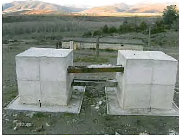
Bloques de hormigón con perfiles IPN. Al fondo, refugio para el personal.
