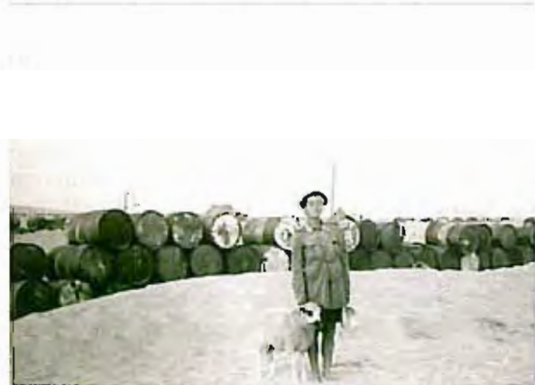
Barriles de combustibles.
