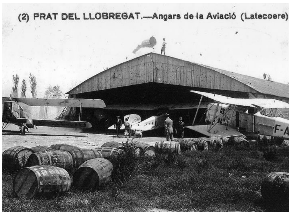
Imagen 8 (s.f.). Hangar de la compañía Latécoère en el término municipal de El Prat (Barcelona). El hangar era del tipo Bessoneau, utilizado por la aviación expedicionaria, y del que también se proveyó la Aeronáutica Naval. Los toneles se utilizaban para transportar el combustible de los aviones, el cual se cargaba manualmente hasta que se ideó el sistema de trasvase de bombeo directo al avión. (Ferret Pujol)
