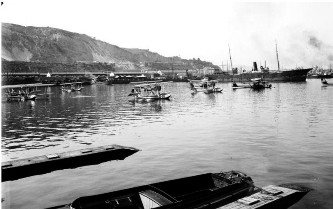
Imagen 23. Hidros en la dársena del Morrot (col. autor; ibídem imagen precedente, ref. A-85)
