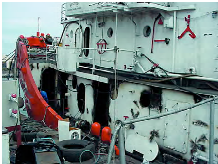
Costado de babor antes de ser cerrado el pasillo de la cubierta principal.
