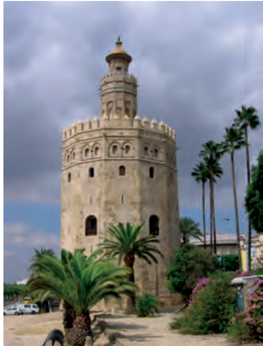
Torre del Oro, Sevilla.
