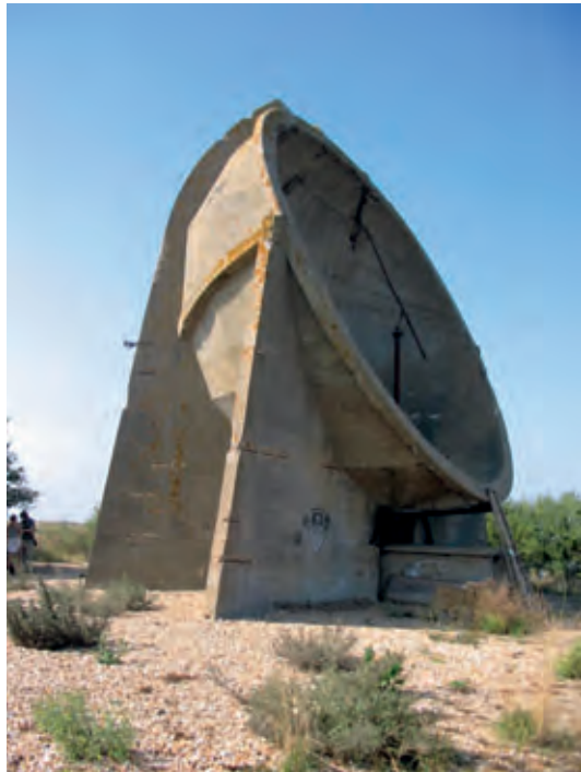
Estado actual de un reflector acústico de 10 m de diámetro. (Fuente: Internet).
