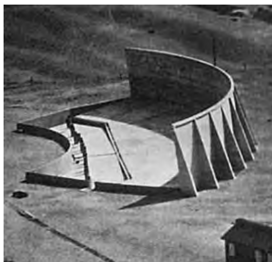
Reflector acústico de 66 metros de largo instalado en Inglaterra.
