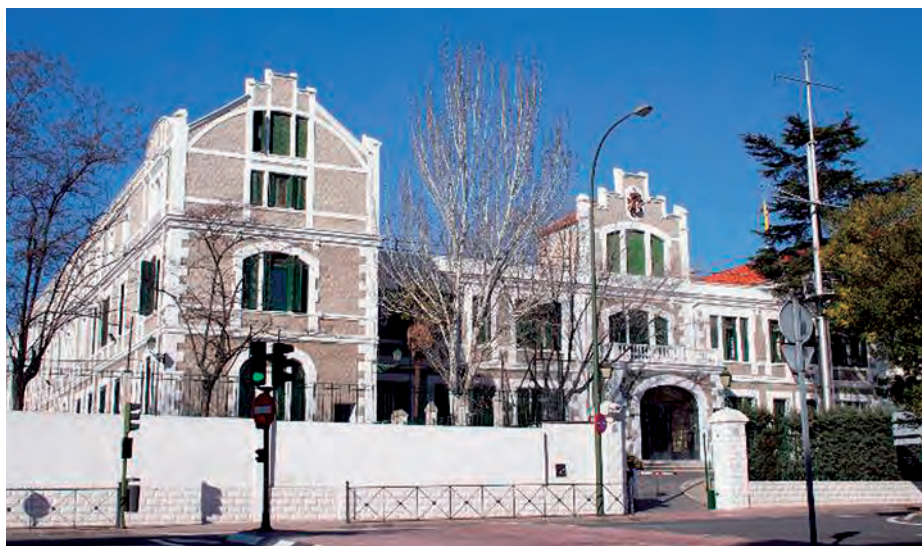
Fachada principal del CHA.
