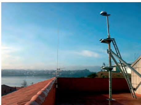
Fig. 5c.—Antenas RADAR, DSC, NAVTEX y FACSÍMIL.
