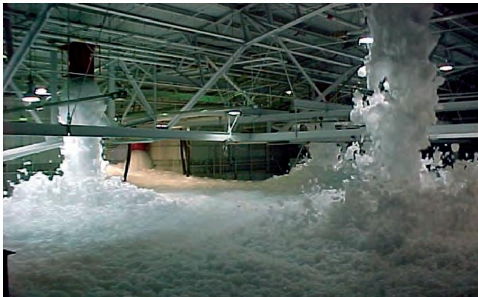
Inundación de un hangar con espuma de alta.
