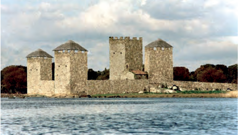
Reconstrucción fotográfica de las Torres Oeste. Catoira, Pontevedra.
