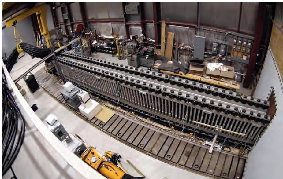
Instalación en polígono de pruebas.
