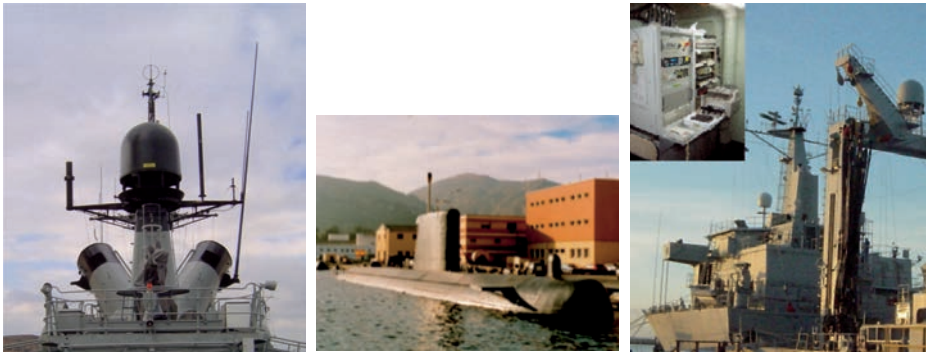
Fig. 4. — Antenas en mástil de un terminal satélite submarino y naval de una antena.
