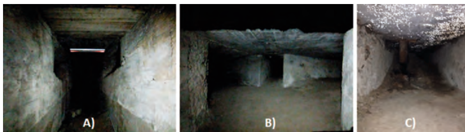
Figura 3. Imágenes detalle del túnel: A) Pasillo central y ramificaciones laterales; B) Trifurcación al final del túnel central, y C) Evidencias de condensación en el interior de una de las ramificaciones laterales.
