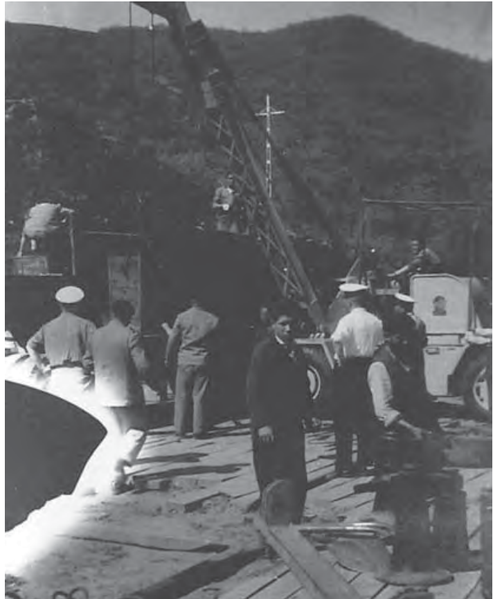
Grúa introduciendo el material del buzo en el camión para su traslado a La Graña.
