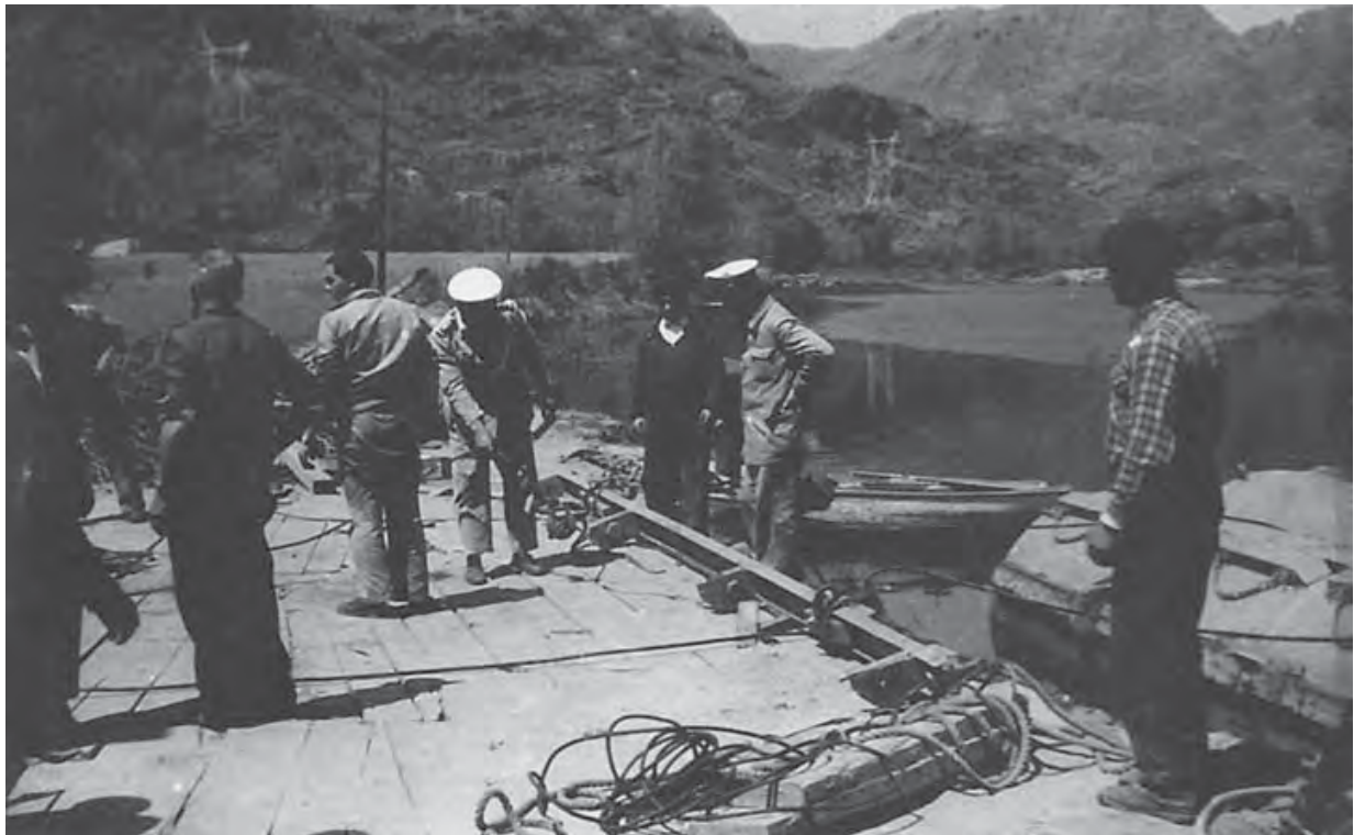
Personal de la Armada instalando un dispositivo para sacar la boya del agua.
