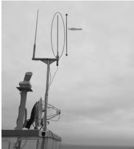
Figura 6. Imagen de la instalación de uno de los nodos en tierra.
