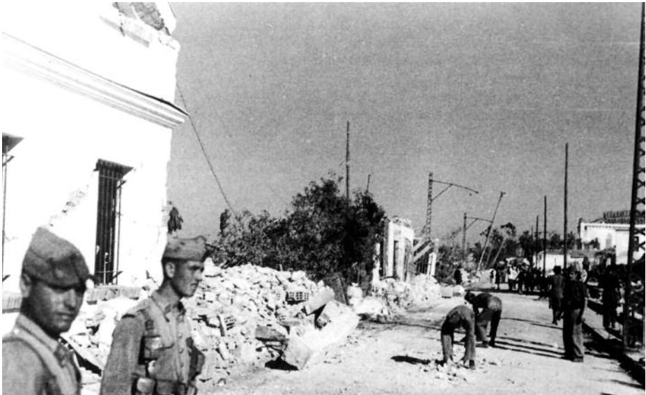
Infantes de Marina trabajando en la limpieza de escombros.
