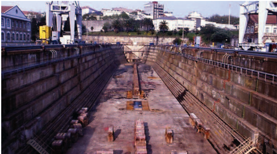
Dique de San Julián de Ferrol. (Foto: ingenieria-civil.org ).
