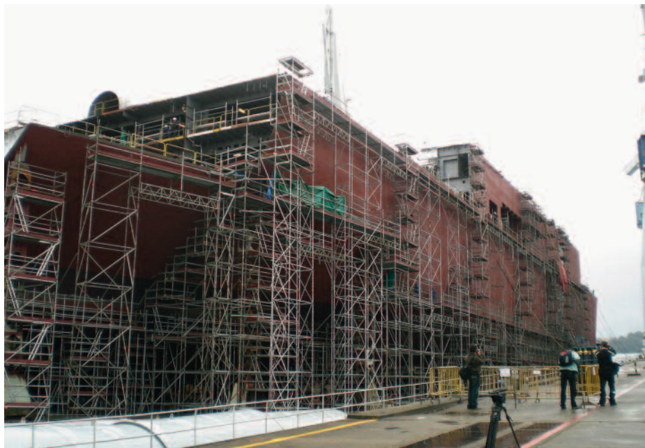
El Juan Carlos I en construcción en 2007 cubierto totalmente de andamios.
