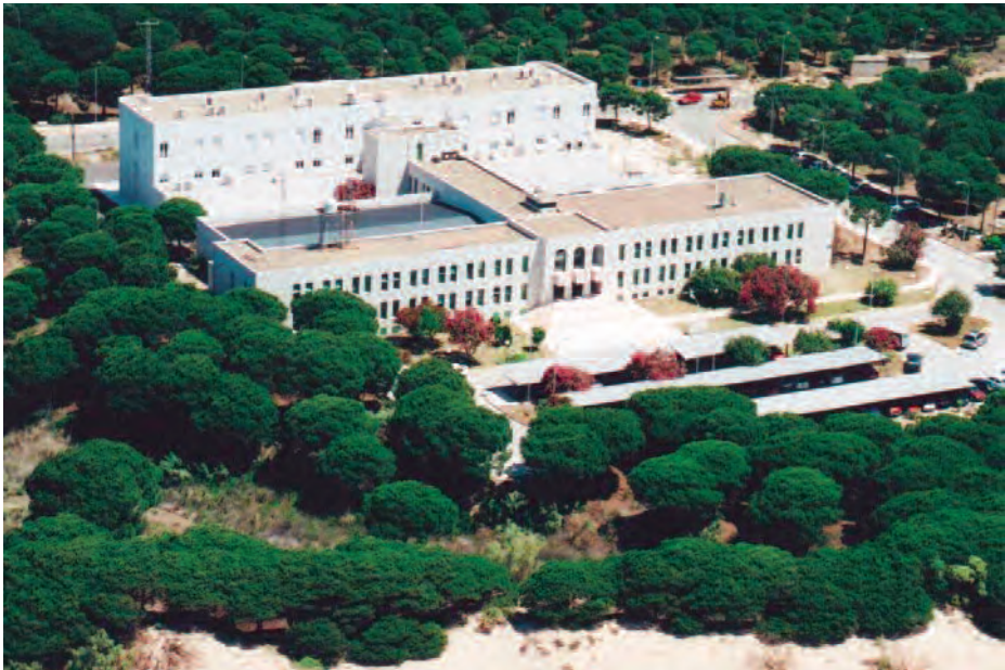
Vista aérea del edificio del CPT-CIA. (Foto: Jorge Flethes).
