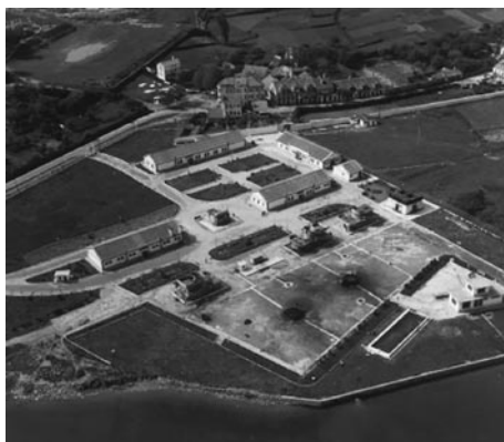
Año 1960. Finalización de las obras. (Fotografía facilitada por el autor)
