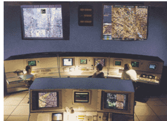
Centros de Control Integrado
