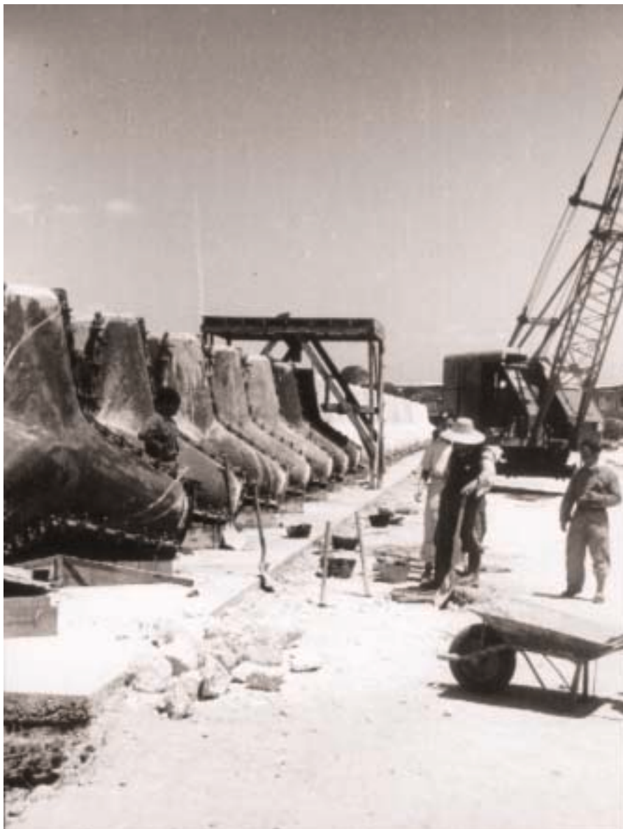
Obras de construcción del puerto. El primer rompeolas fue fortificado con 10.000 tetrapods (1953).
