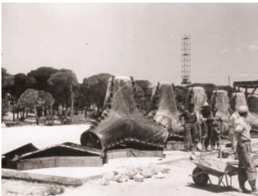
Obras de construcción del puerto. El primer rompeolas fue fortificado con 10.000 tetrapods (1953).
