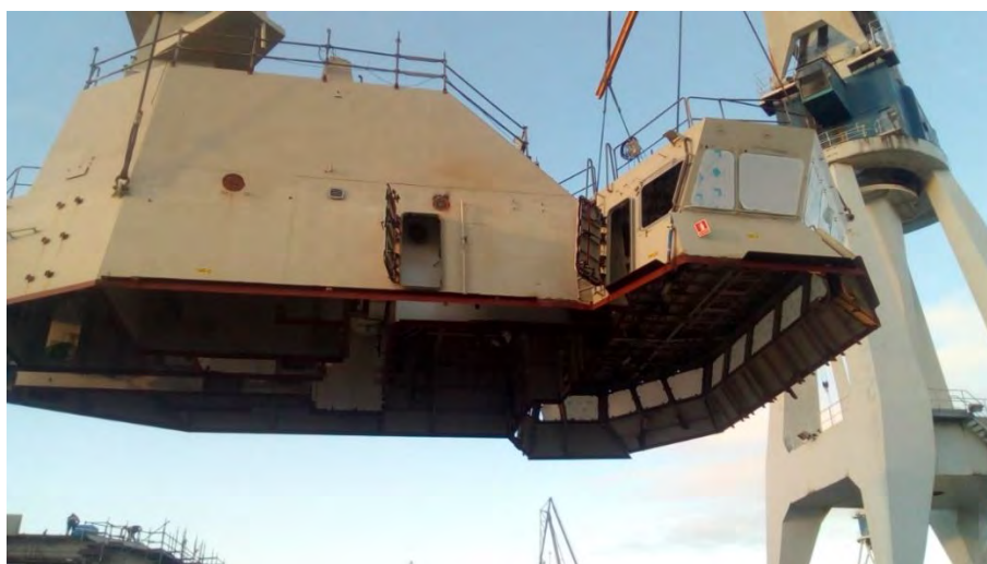
Figura 4: Colocación bloque de proa del BAM Furor (Fuente propia. Año 2017)
