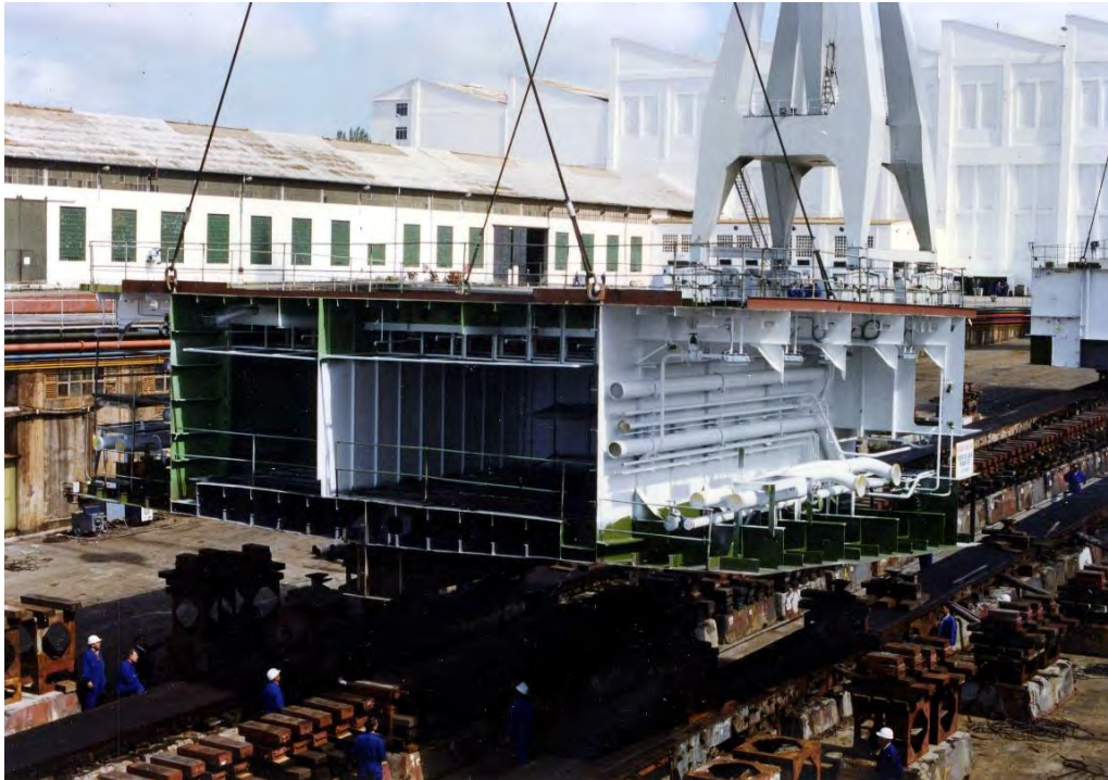
Figura 3: Colocación en grada de bloque de buque LPD en Ferrol (Fuente propia. Año 1996)
