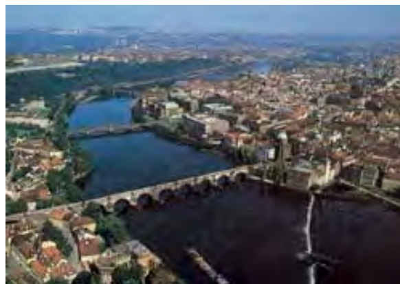
El puente Carlos, de 516 metros de largo por 10 de ancho, se apoya sobre 16 pilares.
