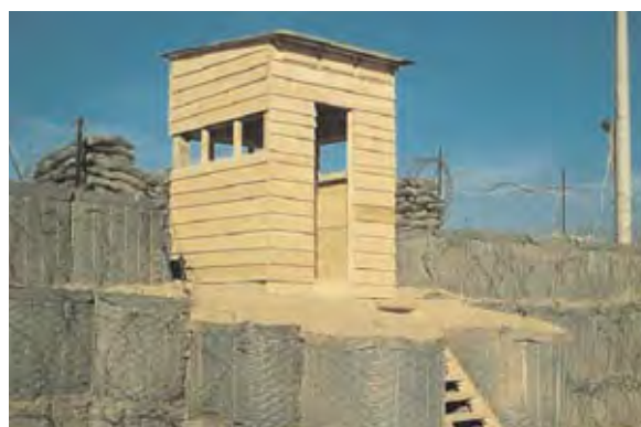
Relleno de contenedores en el control de acceso y garita protegida mediante sistema multicelular, combinada con alambrada rápida y sacos terreros. «Invicta Camp» (Afganistán).
