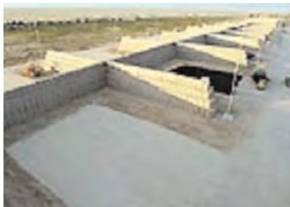
Barrera perimetral en Irak, con disposición en pirámide (izq.) y polvorines protegidos (dcha.)
