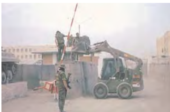
Relleno de contenedores en el control de acceso y garita protegida mediante sistema multicelular, combinada con alambrada rápida y sacos terreros. «Invicta Camp» (Afganistán).
