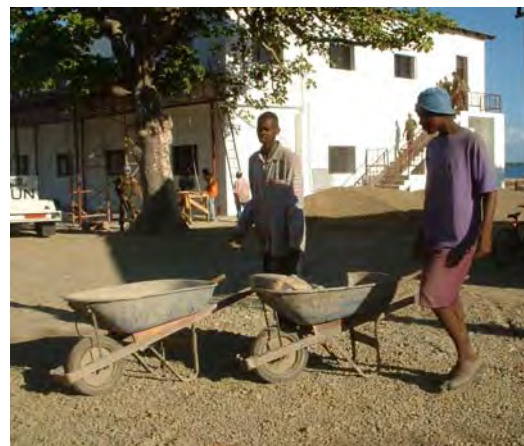
Obras Base Cervantes
