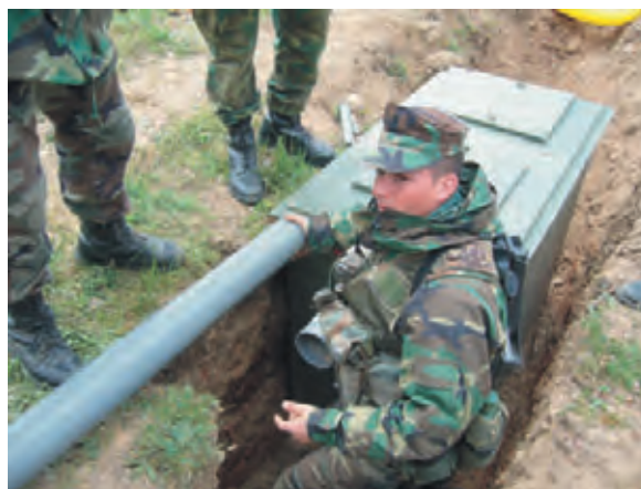
Un componente de la Compañía de Zapadores realizando conexiones en una red de saneamiento de un supuesto campamento, durante el ejercicio EPING-07.
