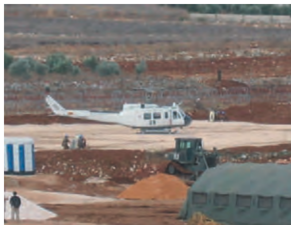
Preparación de una zona de toma de Helos en la Base «Isla de León» en la operación «Libre Hidalgo» en Líbano. Después de la explanación de la zona, se procedió a su estabilización mediante «grava todo en uno».
