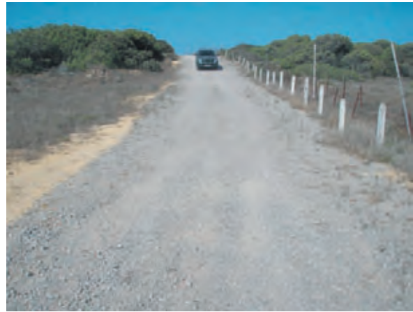
Estado final del camino de Punta Camariñal, después de su habilitación con zahorra y grava «todo en uno». A fecha de hoy, dicho camino sigue presentando este aspecto.
