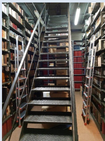
Escalera fija en instalaciones de tierra
