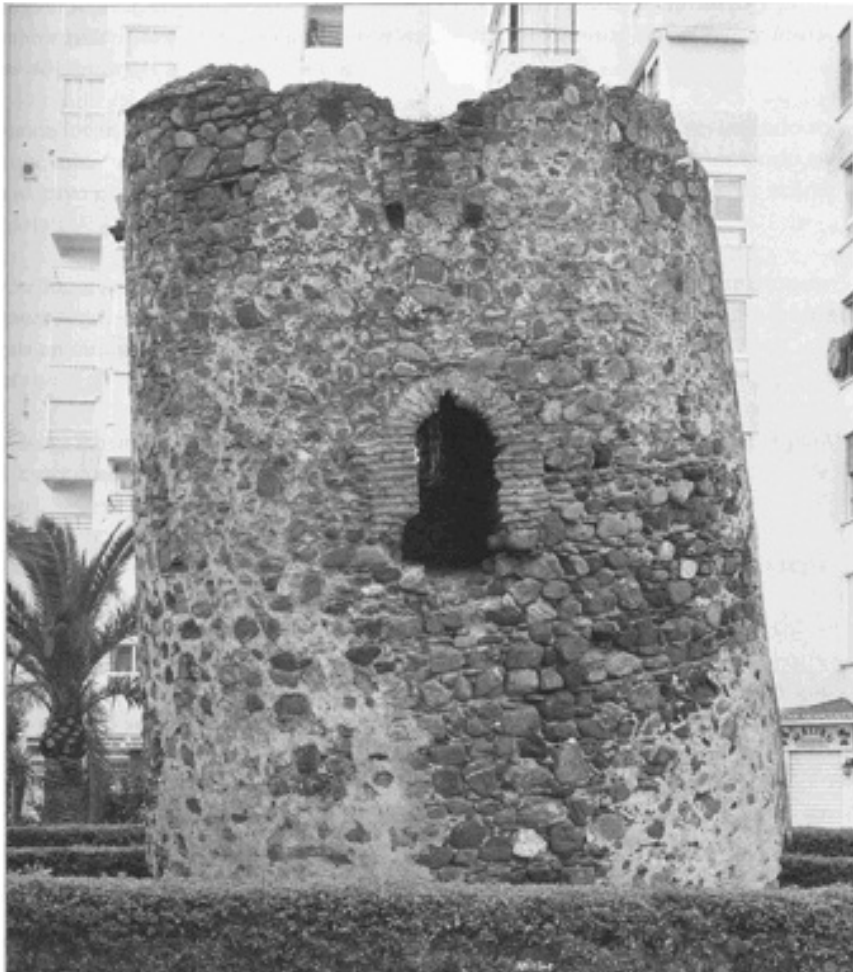
Torre Ladeá (Algarrobo, Granada) (33).
