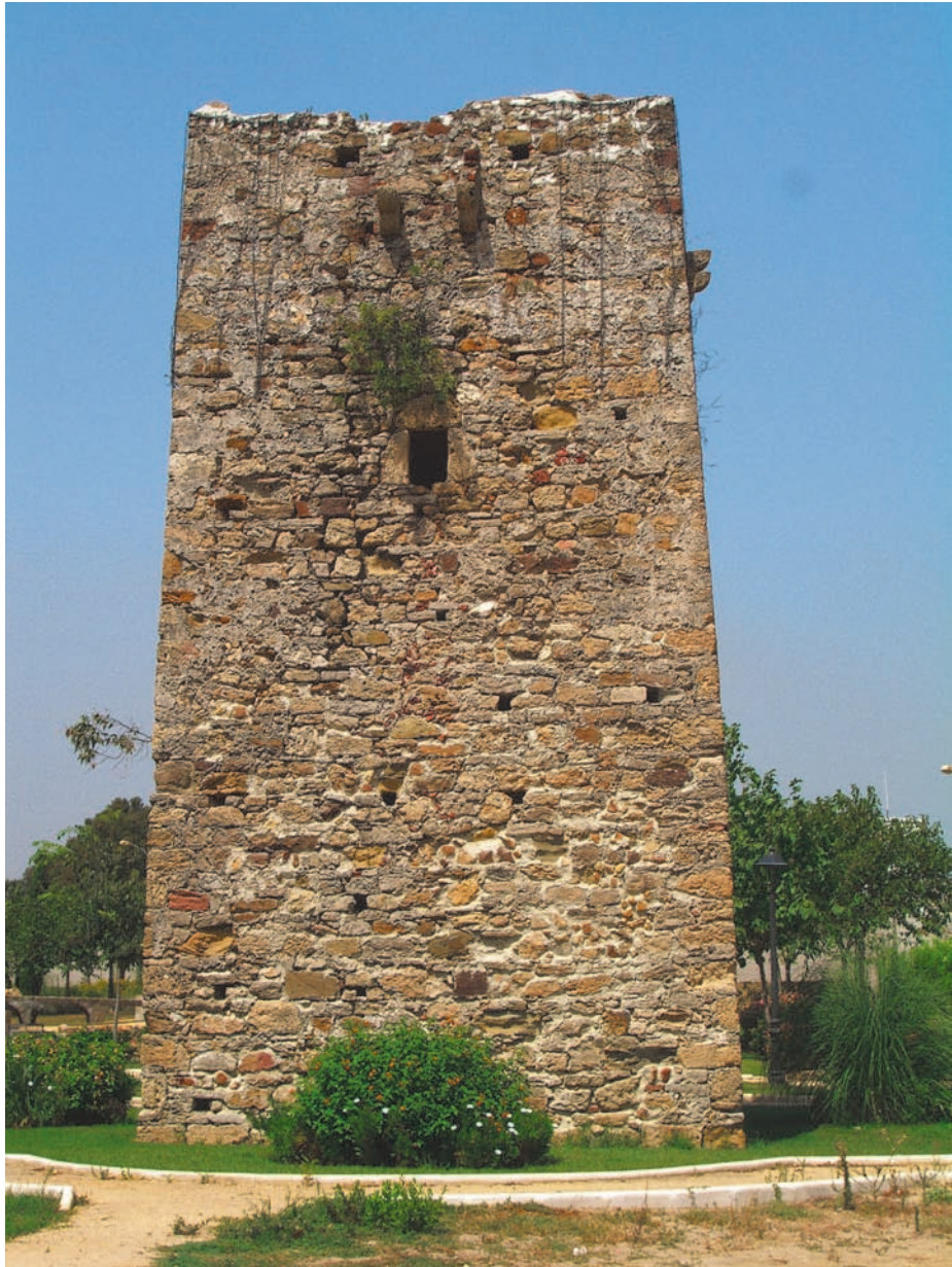
Torre de Entrerríos (Algeciras, Cádiz).
