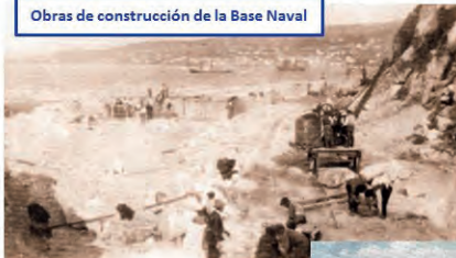
Obras de construcción de la Base Naval
