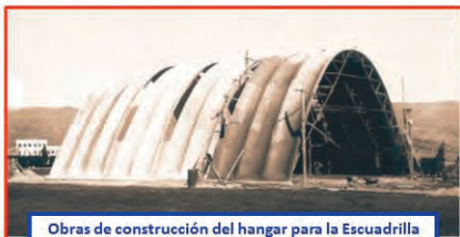
Obras de construcción del hangar para la Escuadrilla de Helicópteros
