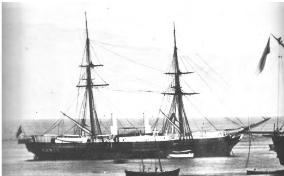
Vapor de ruedas de 2.<sup>a</sup> clase *Cristóbal Colón*, con un desplazamiento de 1.085 t y una artillería compuesta por 2 cañones lisos de 20 cm y 4 rayados de 16 cm
