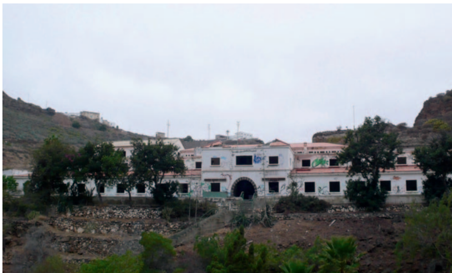
Estado actual del abandonado cuartel de Guanarteme
