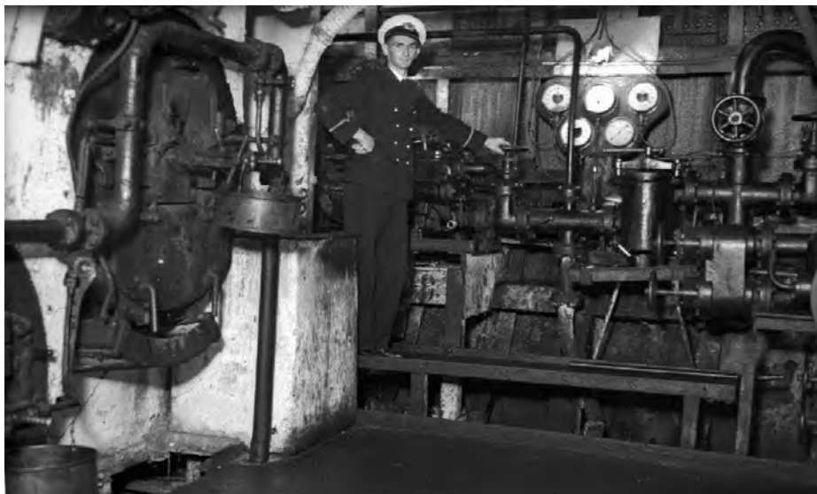
Sala de máquinas del Maori
