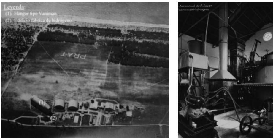
Imagen 13. Panorámica del aeródromo de El Prat, también conocido como «Campo de los Marinos». En la misma se indican: (1) hangar tipo Vaniman, y (2) edificio de la «fábrica de hidrógeno». En la fecha de la fotografía también era el «Aeropuerto Provisional de Barcelona», según la Ley de Aeródromos y Aeropuertos de junio de 1927, con la señal en el suelo identificativa del campo de vuelo ( Fuente: Moragas Bringué, 1928). Imagen 14. Interior del edificio donde se encontraba la fábrica de hidrógeno semifija (transportable) al silicol, instalada en San Javier. (Fuente: Archivo General Militar de Madrid, IHCM, F-12521)
