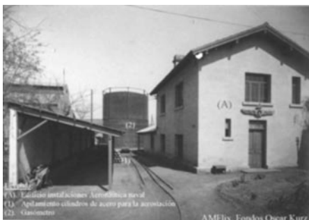
Imagen 10. Instalaciones de la Aeronáutica Naval en la SEQF. En la misma se indican: (A) el edificio con el emblema Aeronáutica, encima del dintel de la puerta; a la izquierda, (1) cobertizo con apilamiento de cilindros; y, al fondo de la imagen, (2) gasómetro. (Fuente: Archivo Municipal de Flix, fondo Oscar Kurz [técnico alemán de la SEQF])
