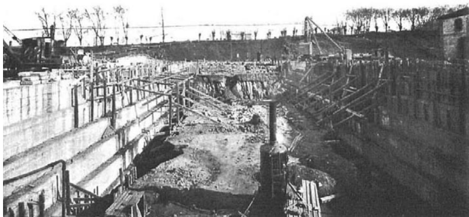
Arsenal de Ferrol. Obras del nuevo dique. SECN, 1910 (FUENTE: BNE)
