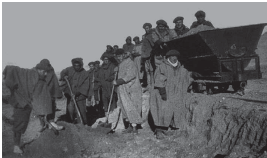
Construcción del ferrocarril Transahariano.
