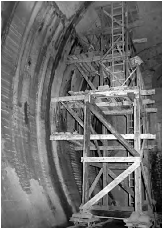
Pared lateral del túnel núm. 1. (Foto: Navantia).
