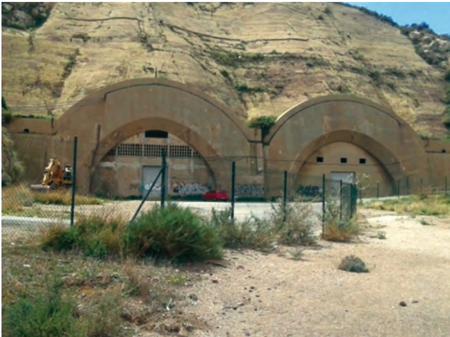
Entrada a los túneles de Espalmador Grande.
