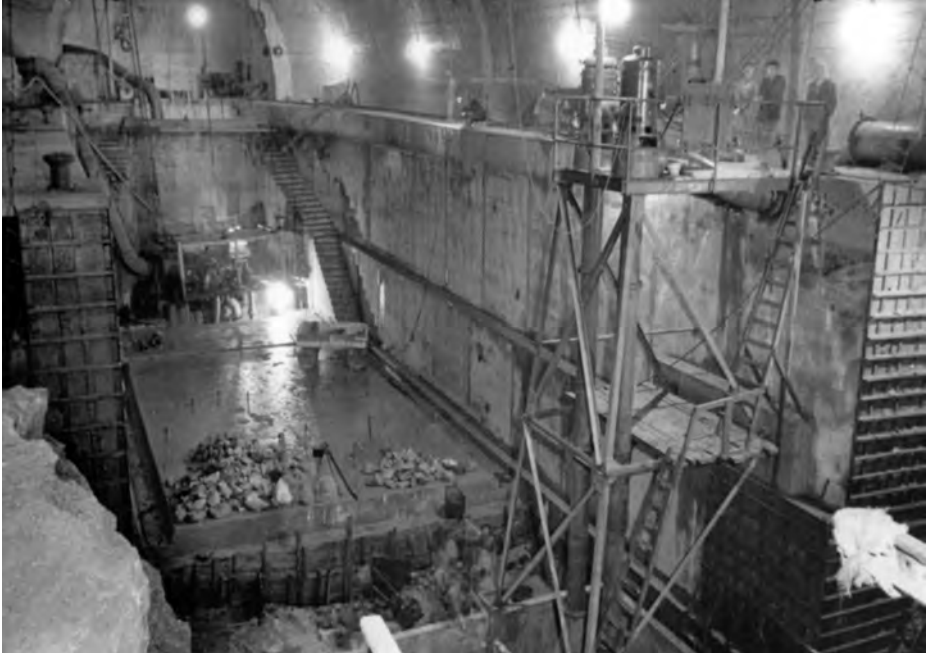
Construcción del foso del dique del túnel núm. 1. Cartagena, 22 de diciembre de 1956. (Foto: Navantia).
