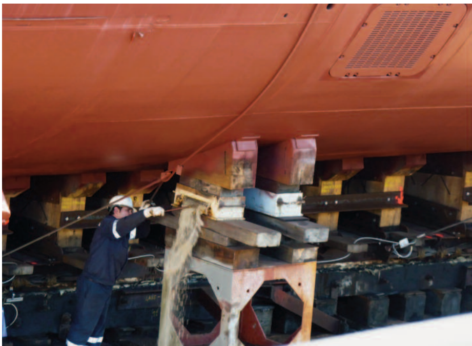
Figura 10. Operario actuando sobre una caja de arena.
