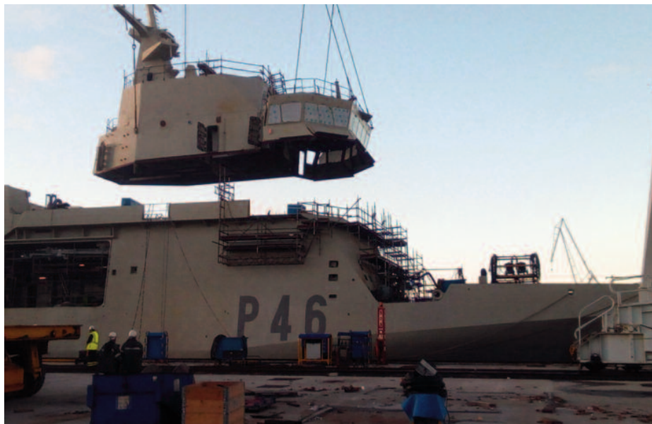
Colocación del bloque del puente de gobierno en el buque de acción marítima Furor en diciembre de 2017.
