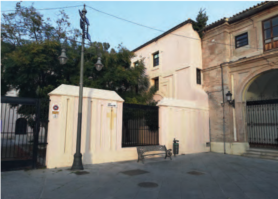
Detalles de la entrada y de la fachada del antiguo Hospital Militar de Málaga. Anexo, el Santuario de Nuestra Señora de la Victoria. (Fotografía de Francisco Javier Roca Fernández).
