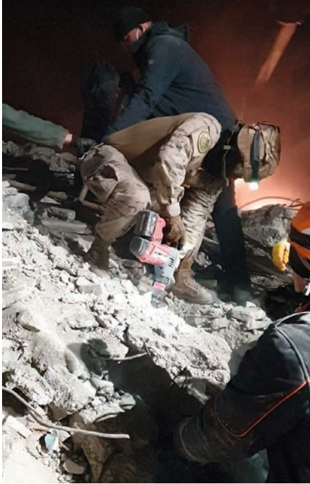
Equipos de rescate españoles y turcos trabajando mano a mano. (Foto: BRD 223)
